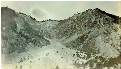
「千石ずり」と呼ばれた荒廃地
