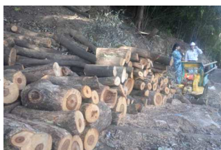
新神戸駅北斜面で広葉樹を伐採
