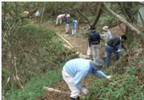
近畿自然歩道の斜面のササ刈り
