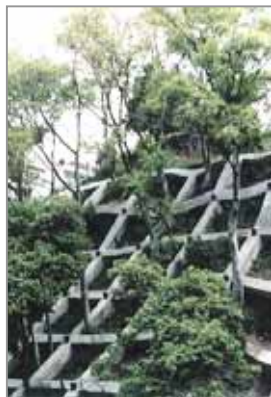
既存植生を保全した 法枠工
