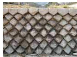
籠積堰堤(よろいづみえんてい)
