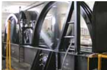
ケーブルの巻き上げ機
