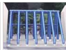
スリット型の堰堤
