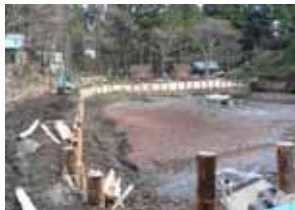
改修中の星野池
