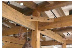
束ね工法の梁と柱
