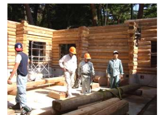
建築中のログハウス
