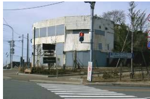
改築前の建物
