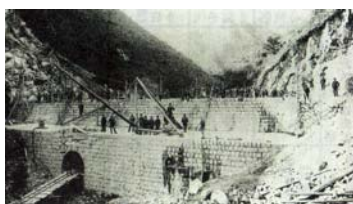
施工中の布引水源
