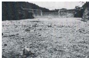
土砂で埋まった五助堰堤（ダム）
