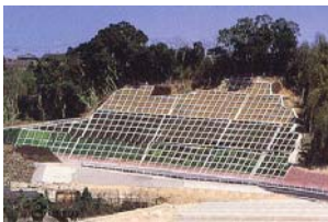
コンクリート枠工
