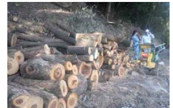
新神戸駅北側での整備 / 神戸市建設局防災部
