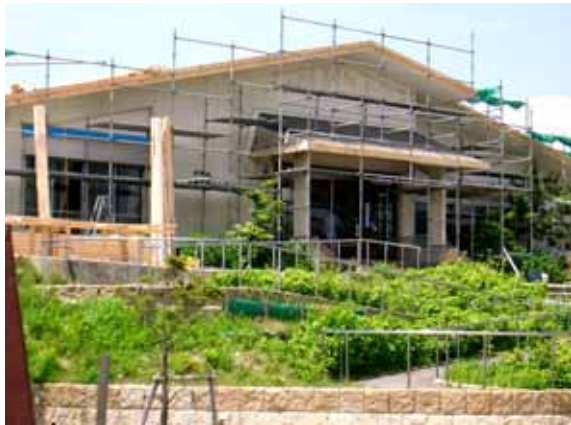
改修中の自然保護センター
