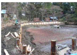
改修中の星野池
