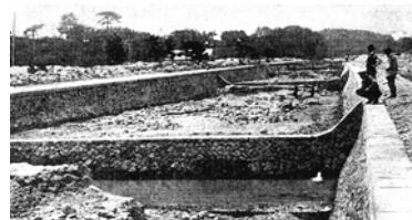
逆瀬川の流路工(昭和7年ごろ)
