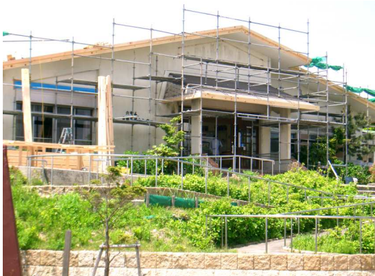
改修中の自然保護センター
