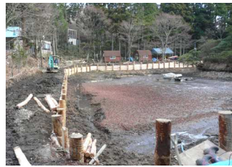
改修中の星野池
