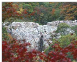
コンクリートの表面を加工した堰堤
