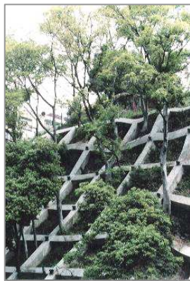
現存植生を保全した 法枠工
