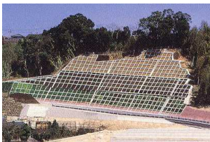
コンクリート枠工
