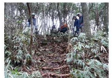
アセビの腐材で階段を設置
