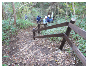
坂道に木柵を設置
