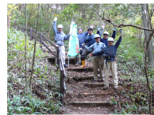
木柵設置工事が完了を設
