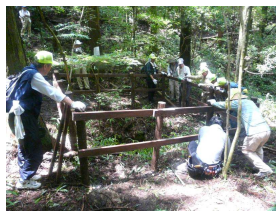
安全柵の設置
