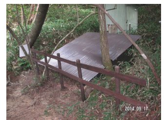
屋根の改修・安全柵
