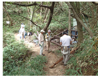
ポンプ小屋前で工事
