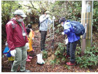
27 第30番の標柱設置
